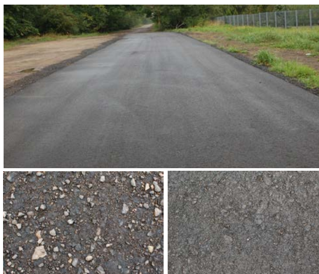
Fot. 3. Test jednego z odcinków drogowych o nawierzchni z betonu asfaltowego na bazie granulatu: a) widok odcinka „szutrowego”, destruktu asfaltowy po zawładowaniu na zimno, b) przetworzony granulat asfaltowy z tej samej partii destruktu co na odcinku „szutrowym”, w metodzie na ciepło w temperaturze 1200°C
